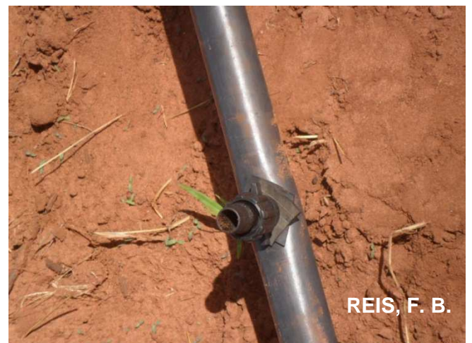
ANEXO 4. Instalação de Irrigação
