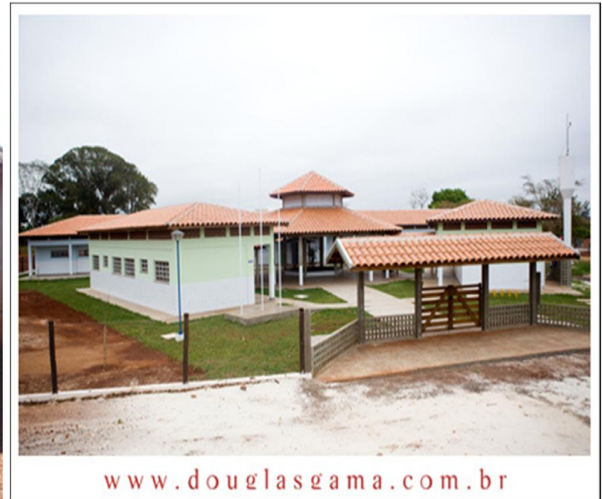
Prédio da escola Guateka, substitui casa de pau a pique que existia anteriormente.
