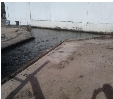
Figura 11. Local de captação da Sanesul no município de Mundo Novo/MS
