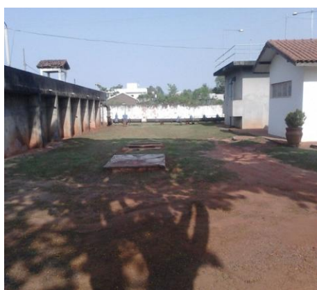
Figura 9. Pátio da ETA da Sanesul no município de Mundo Novo/MS.
