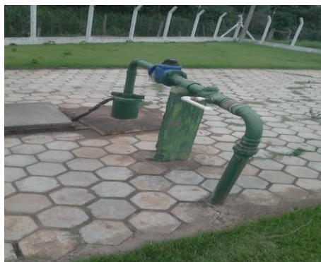
Figura 17. Poço artesiano no MUN 005.
