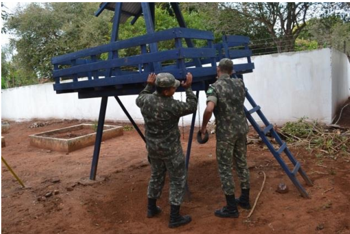
Figura 10: Restauração e instalação do parquinho infantil – Casa da Criança
