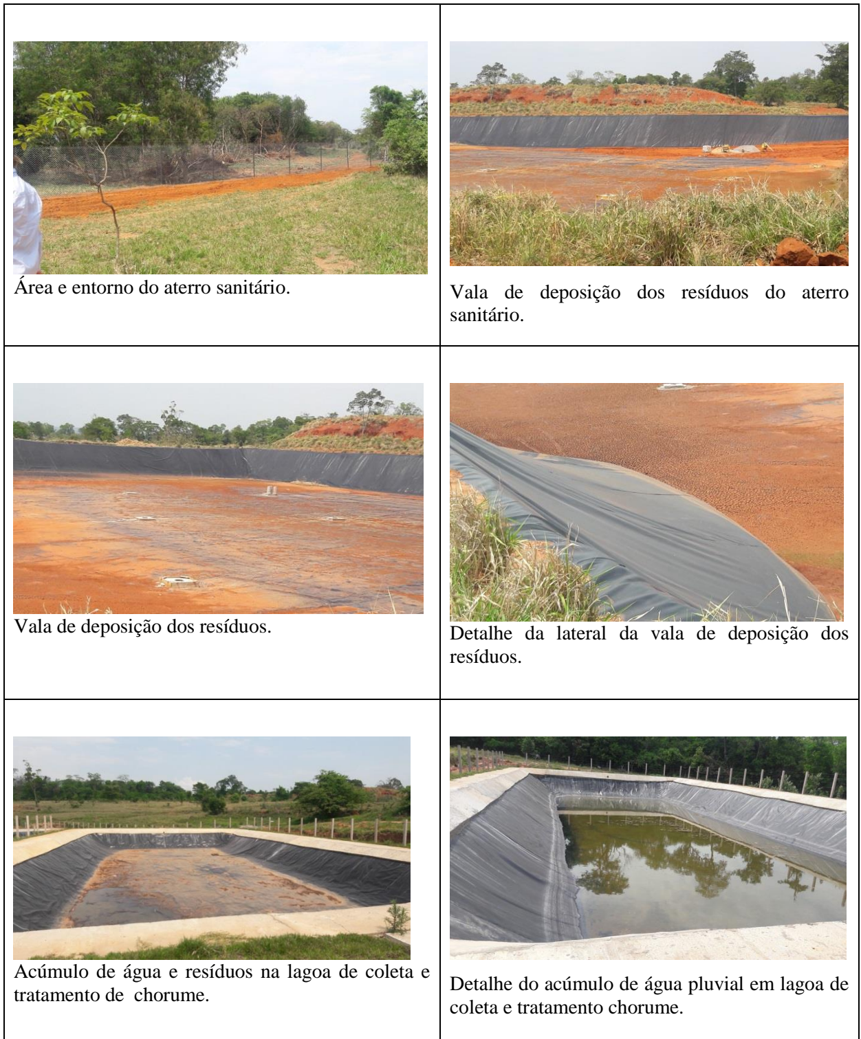
Figura: 22 Coletâneas de fotos do Aterro Sanitário de Jardim/MS – Outubro, 2017.
