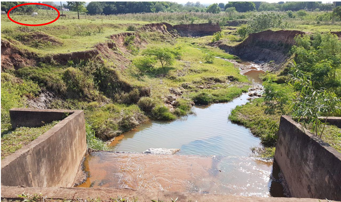
Figura 15 – Água do córrego usada para dessedentação animal. Continuação do canal do córrego Grotão, após o trecho canalizado, com destaque para a presença de bovinos na área monitorada, a erosão não é causada apenas pelo processo natural, mas com influência de uso do solo para pecuária. Fonte: Elaborado pelo autor.
