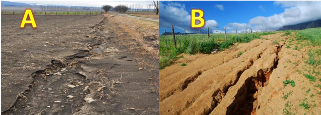
Figura 10 – Exemplos de sulcos e ravinas. A – Os sulcos são comuns em beiras de estradas e rodovias. B – As ravinas geralmente são encontradas em plantações. Fonte: http://brasilecola.uol.com.br .
