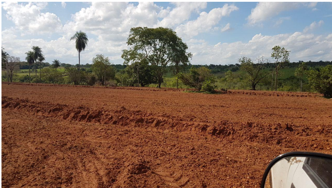
Figura 23 – Curvas de nível utilizadas como medidas de contenção.
