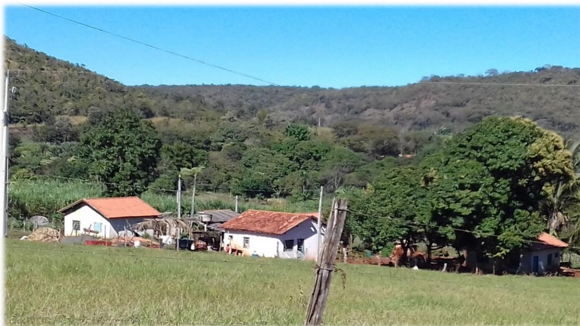
Figura 7: Comunidade Quilombola “Furnas do Dionísio” – habitações de alvenaria
