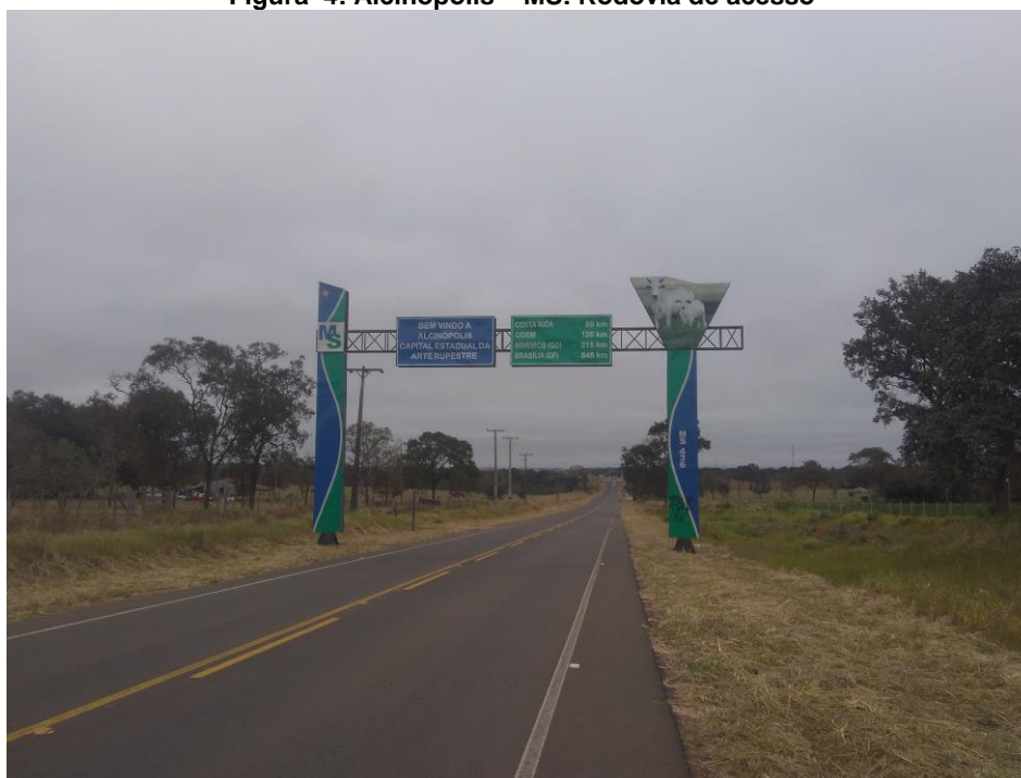
Figura 4: Alcinópolis – MS: Rodovia de acesso
