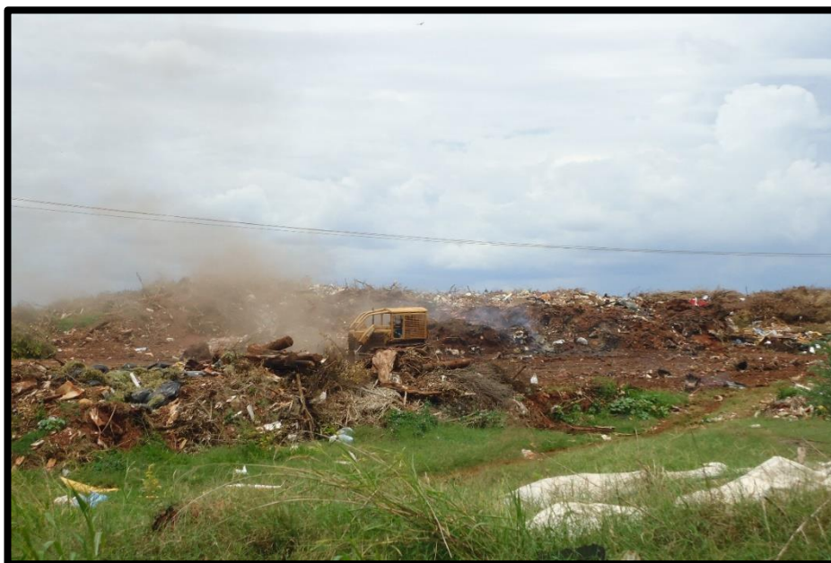
Foto 04: Máquina fazendo o trabalho de cobertura do lixão de Jardim/MS Fonte: Bartha (2016)
