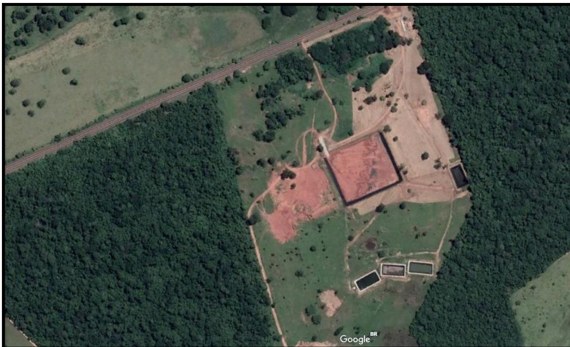
Figura 08: Vista do Aterro Sanitário em construção via Satélite
