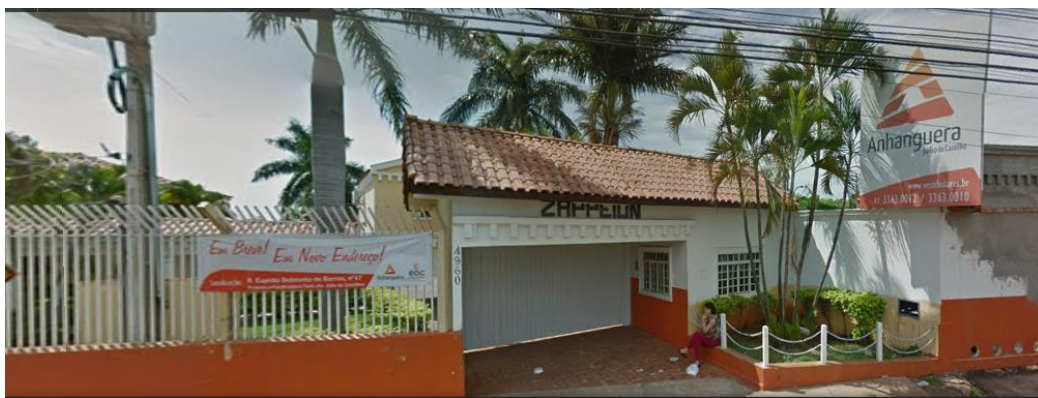
Figura 4: Vista frontal do prédio provisório de funcionamento do Campus Campo Grande
