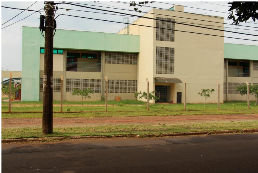
Figura 13: Bloco de salas de aula – sede definitiva do Campus Campo Grande
