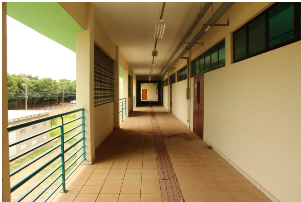
Figura 14: Bloco de salas de aula e laboratório – sede definitiva do Campus Campo Grande
