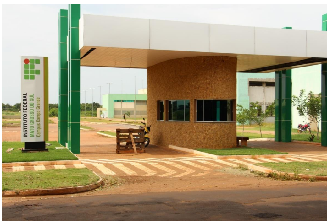
Figura 12: Pórtico de entrada da sede definitiva do Campus Campo Grande
