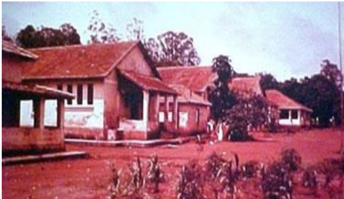
Figura 2 – Área dos doentes – casas germinadas para famílias acometidas com o bacilo da Hansen. Fonte: ARAÚJO, 1928.
