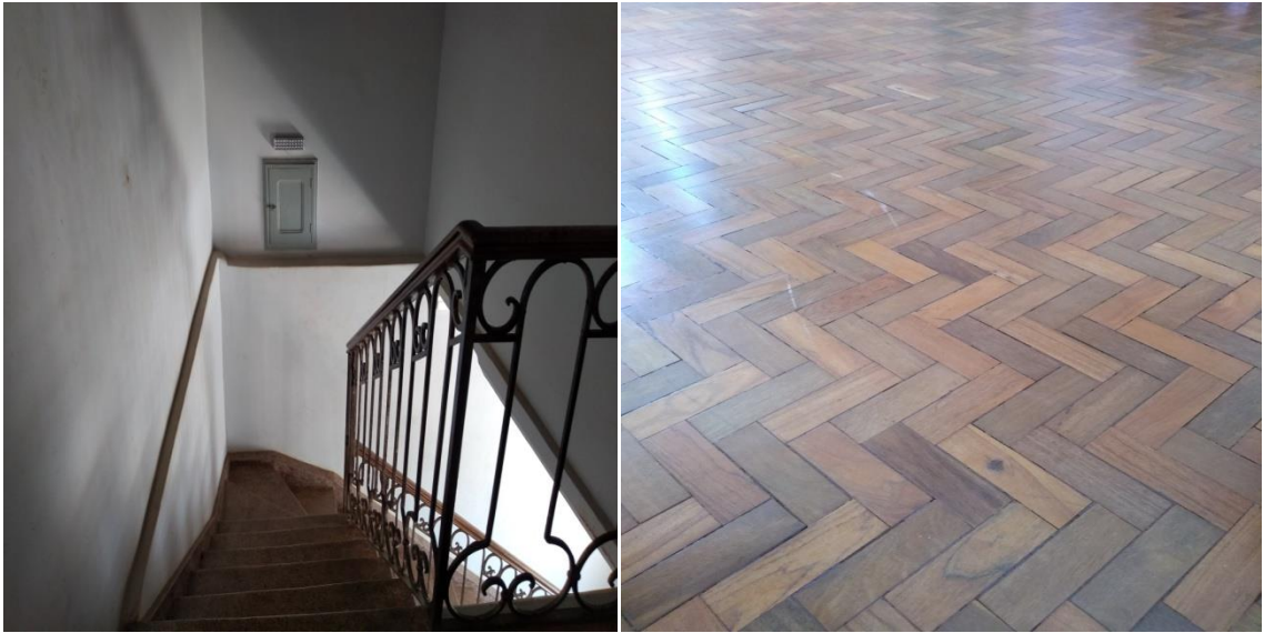
Figura 15 Sala do CCO - pequenos detalhes: escada de acesso e assoalho de madeira
