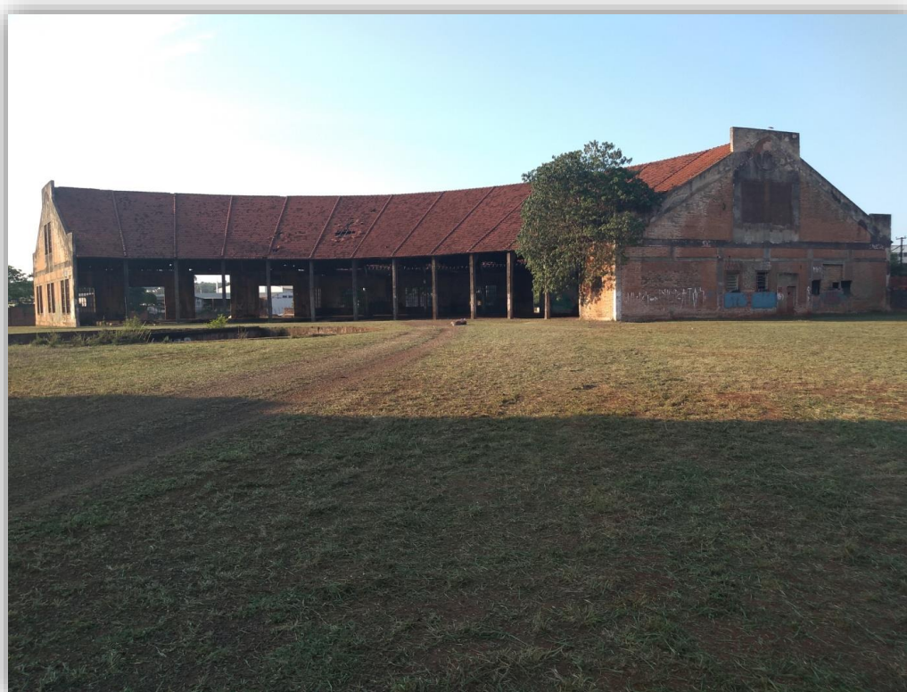
Figura 6: A Rotunda do Complexo Ferroviário de Campo Grande - MS
