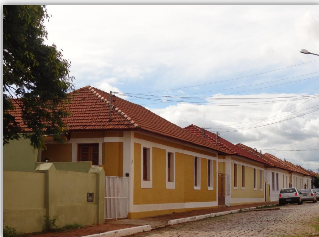
Figura 8: Vila dos Ferroviários - Rua Dr. Ferreira - Campo Grande - MS
