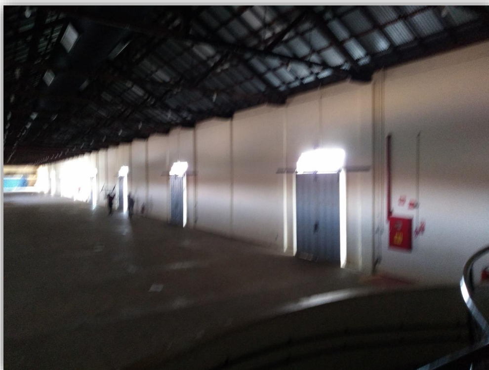
Figura 5: Armazém Ferroviário de Campo Grande - MS
