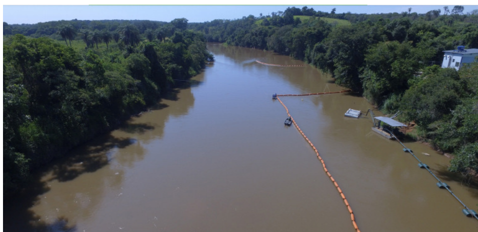
Figura 4. Membranas de contenção de rejeitos ao longo do rio Paraopeba, MG. Fonte: (Vale, 2019).
