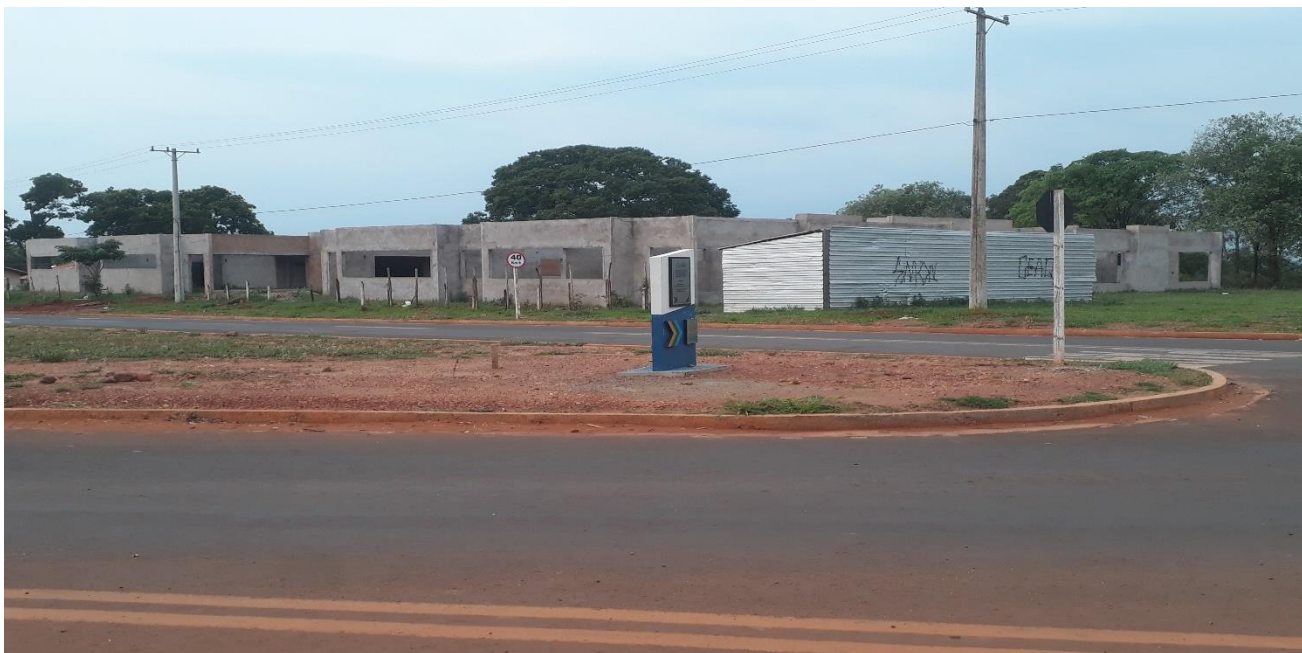
Imagem 9: Área da CIEI- Ed. Infantil em fase de construção no Bairro João Martins Barbosa em Jardim-MS Org. DUARTE, Kélvis, 2019.
