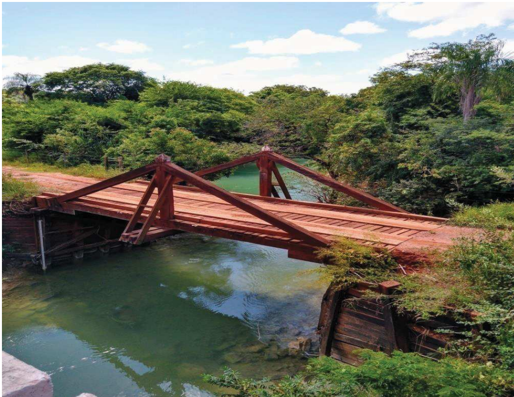
Figura 25: Ponte desativada sobre o Rio Prata Fonte: Da autora. 14 de abril de 2019
