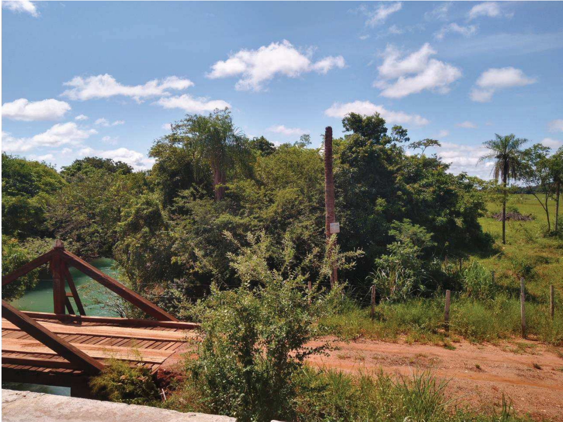
Figura 27: Ponte desativada sobre o Rio Prata Fonte: Da autora. 14 de abril de 2019
