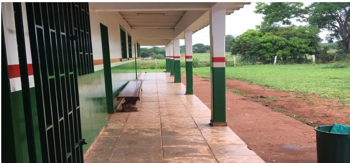
Figura 5. Foto do corredor externo que dá acesso ao pátio da escola. Fonte: arquivo da autora. Registro de agosto de 2019.
