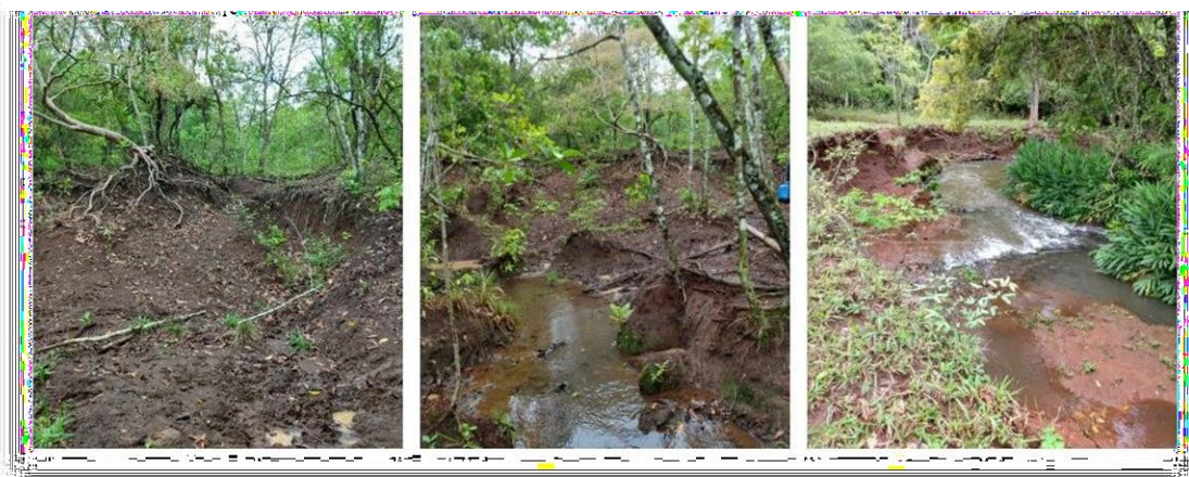
Figura 35: Córrego Ceroula - focos de assoreamento
