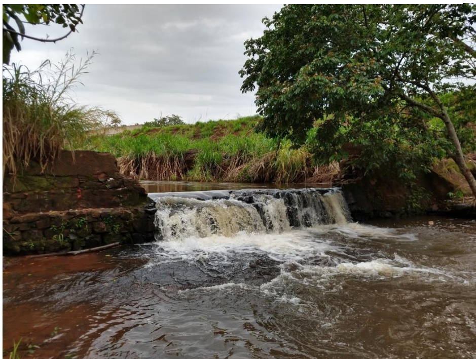
Figura 18: Ruínas da antiga "Pontezinha"
