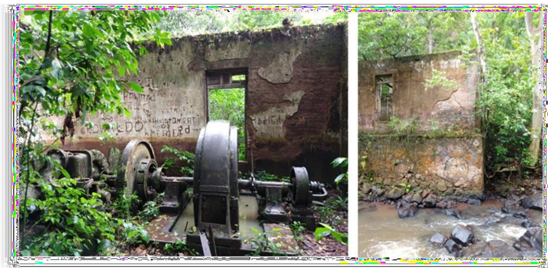
Figura 34: Usina do Ceroula - equipamentos e vandalismo
