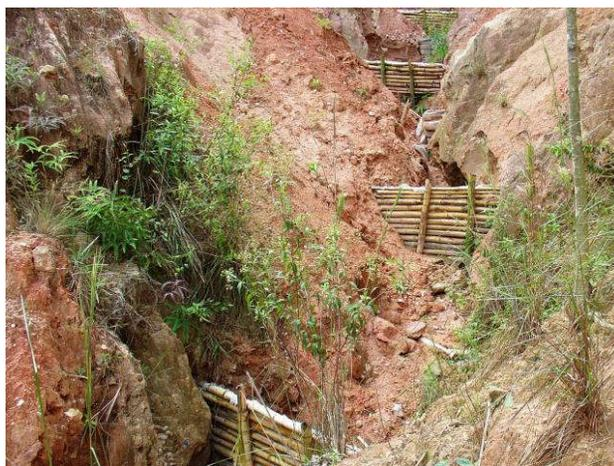
Figura 7. Imagem ilustrativa indicando como devem ser dispostas as paliçadas na voçoroca. Fonte: RESENDE (2007).
