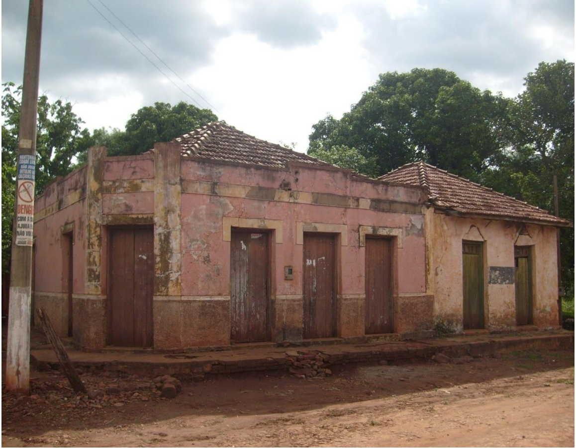
Figura 3. Fachada residencial – Distrito de Bom Fim Fonte: Própria, 2014.
