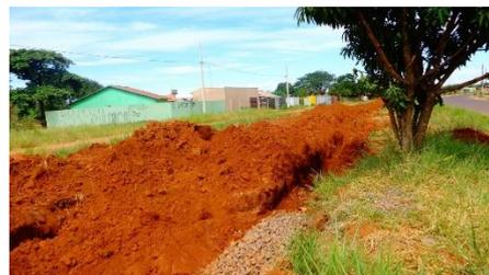
**Figura 7:** Março dia 26. Obra para contenção do afloramento do lençol freático em conclusão.
