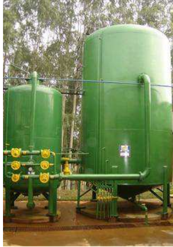
FIGURA 23 – ETA compacta.
