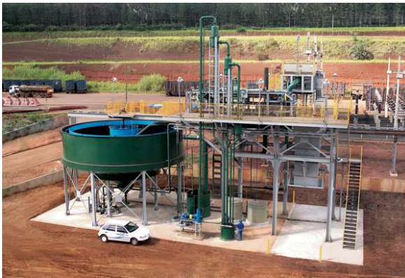
(A) Clarificador de água de fuligem.
