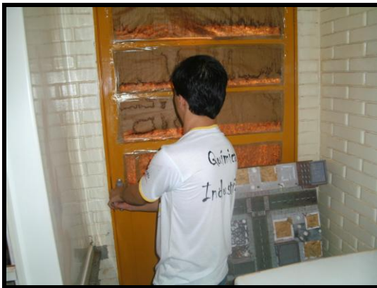
FIGURA 46 - Porta obstruída (ago/2012).
