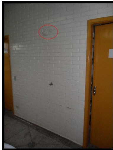
Figura 19 - Acesso ao chuveiro desobstruído (out/2012).
