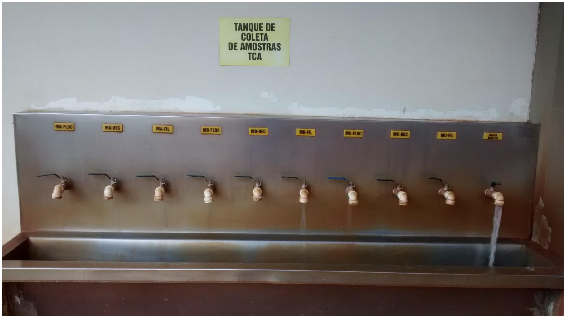
Figura 12 – Tanques de coleta das amostras de água bruta e tratada em diferentes etapas do tratamento
