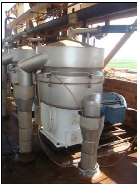
Figura 29: Centrifugas
