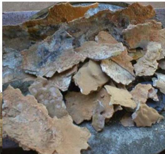
Figura 13: Incrustações retiradas da caldeira.
