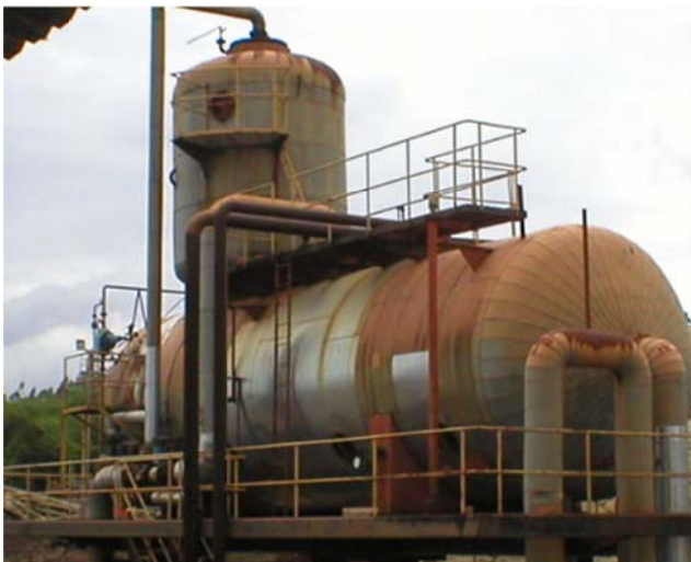
Figura 12: Foto de um desaerador.
