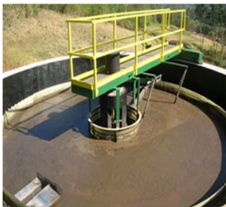
Figura 17: Decantador
