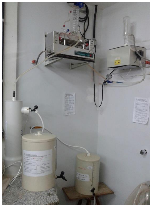
Figura 6 – Sistema de destilação de água do laboratório CPBio.
