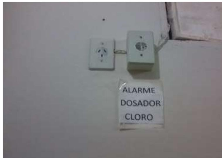
**Figura 16** – Alarme dosador de cloro.
