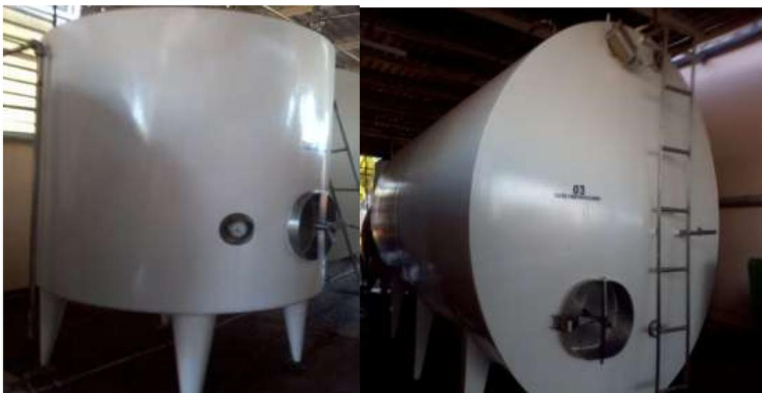
**Figura 24** – Balões de armazenamento de leite pasteurizado. Laticínios Camby.
