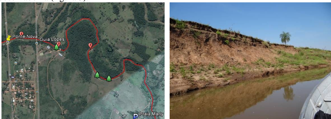
Figura 5- Imagem oblíqua da margem esquerda do rio Miranda onde se constata a ausência de vegetação.
