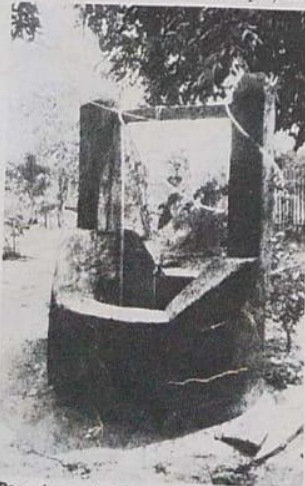
Poço da casa de Bião.
