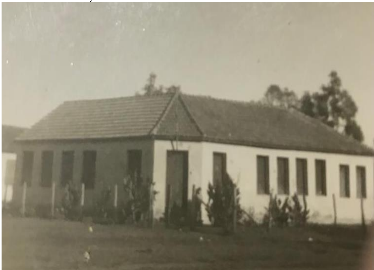
Figura 16. Edifício cuja construção foi iniciada pelo professor Martim Honésimo da Fonseca, que abrigou a Escola Visconde de Taunay
