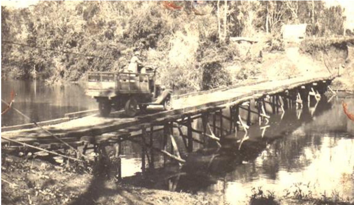
Figura 2. Primeira ponte construída sobre o Rio Miranda pelo 6º Batalhão de Engenharia, entre 1934 e 1935.
