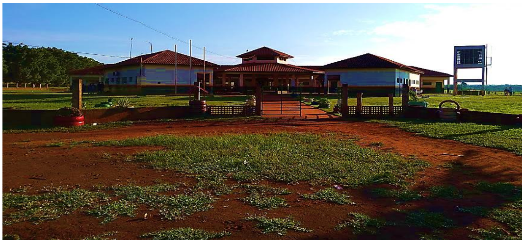
Figura 2 - Escola – estrutura exterior
