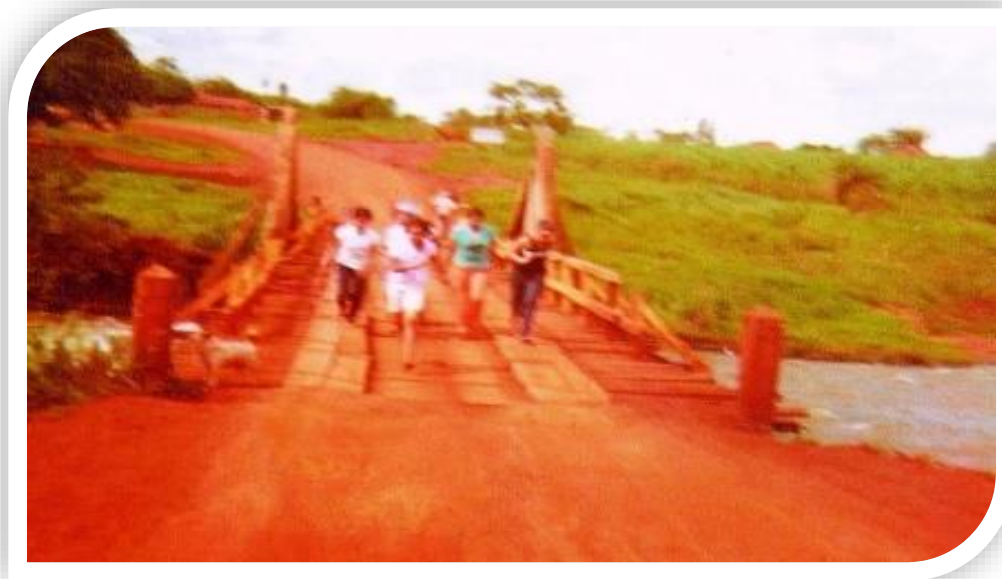
Figura 4 - Ponte sobre o rio Sucuriú
