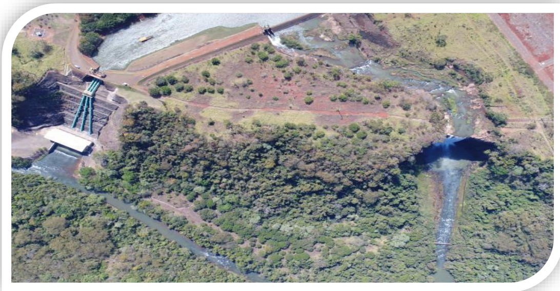
Figura 10 - Hidrelétrica de Costa Rica – Rio Sucuriú
