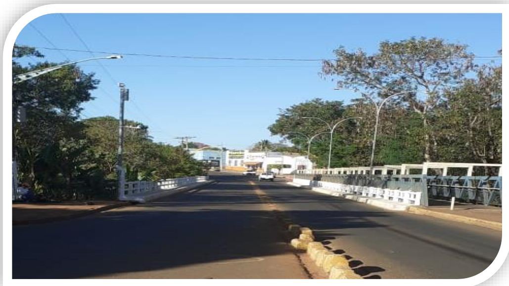
Figura 5 - Foto atual da Ponte sobre o rio Sucuriú
